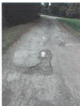
Réfection voirie rue des Bergers 2 ème partie
