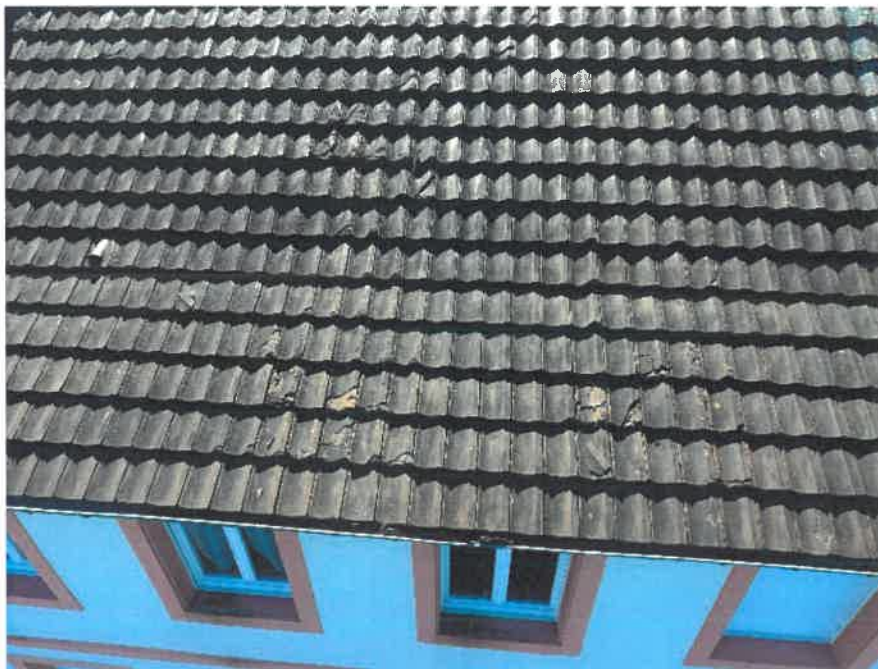
la Réfection de la toiture de l'école
