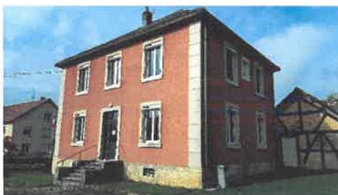
Travaux mairie (façades – atelier – assainissement)
